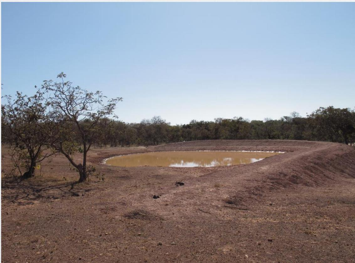
Fotos: exemplo de serviço ambiental prestado pelo produtor ao realizar barraginhas em solos adequados que servem para conter a água da chuva e permitir que elas infiltrem, chegando ao lençol freático.
